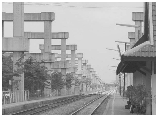
図-4 ホープウエルの橋脚
