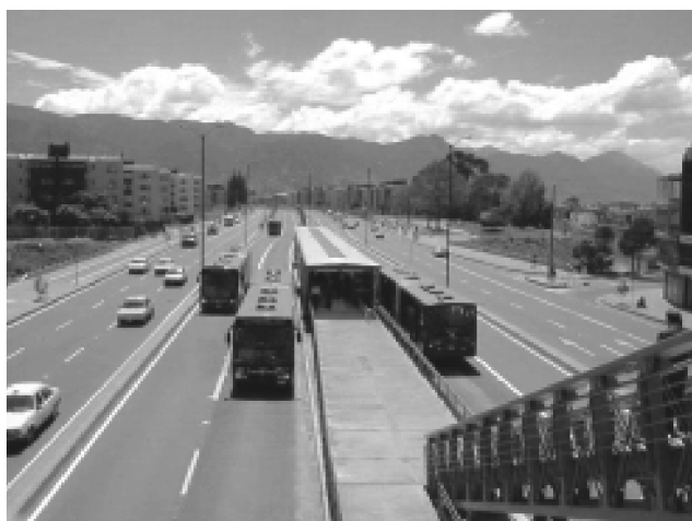
図-1 片側2車線のバス専用レーン 2)
