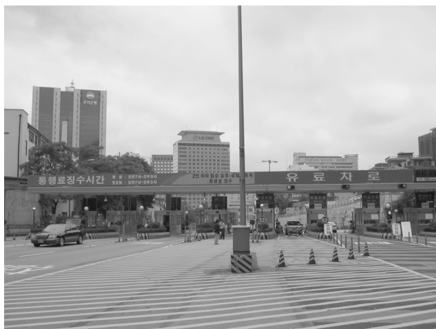
写真-1 南山トンネル 3 号線料金所
