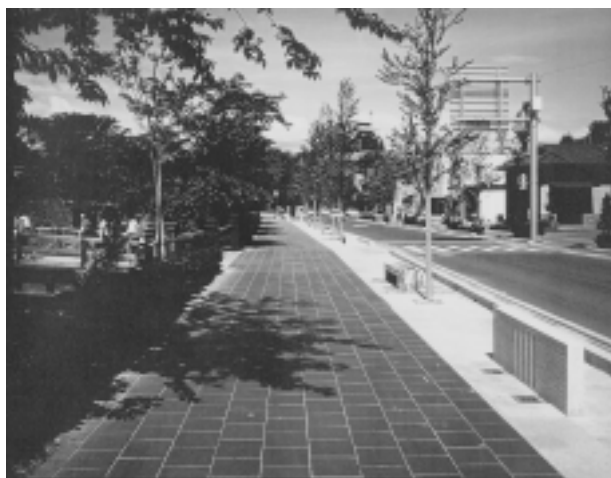
写真-5 松本城北側の宮新橋上金井線(施工後)
