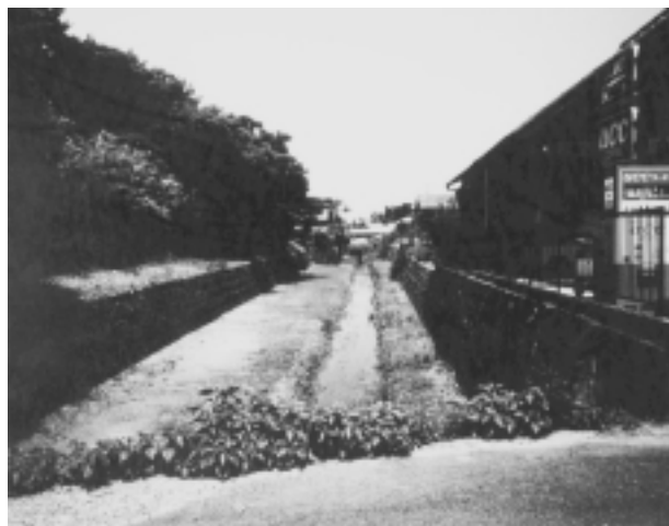
写真-1 今魚店金谷線沿いの外堀（施工前）
