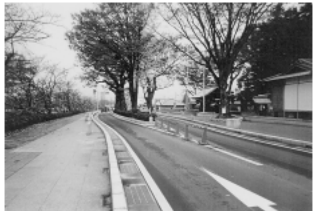
写真-4 宮渕新橋上金井線（施工後）
