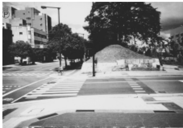
写真-7 城東線の総社門東面(整備後)
