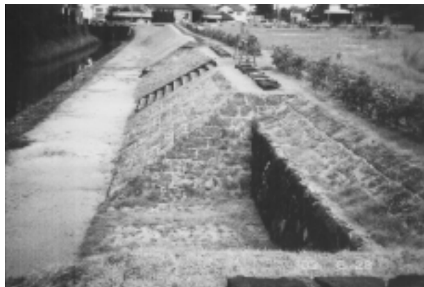
写真-2 今魚店金谷線沿いの外堀（施工後）
