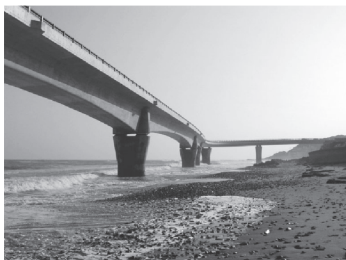
写真-1 海岸線を通る既供用区間（旭町付近）
