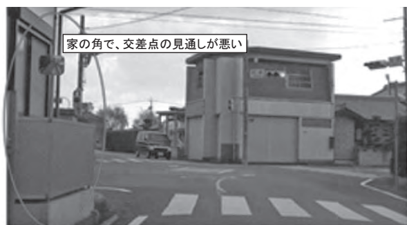
図－8 三重県道 60 号前野交差点付近の様子
