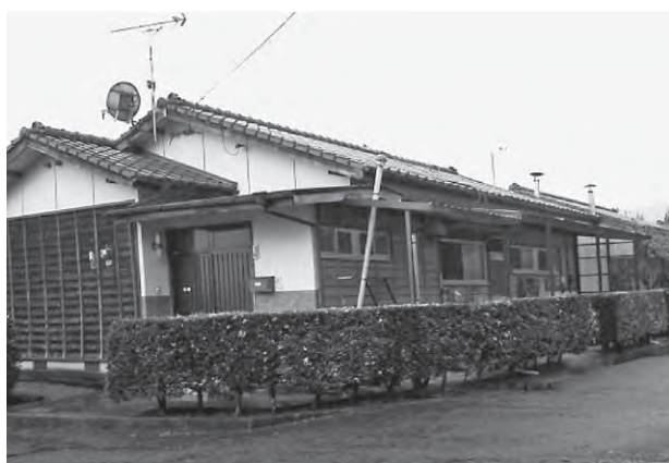
写真-1 移転先の市営住宅（福王寺地区）
