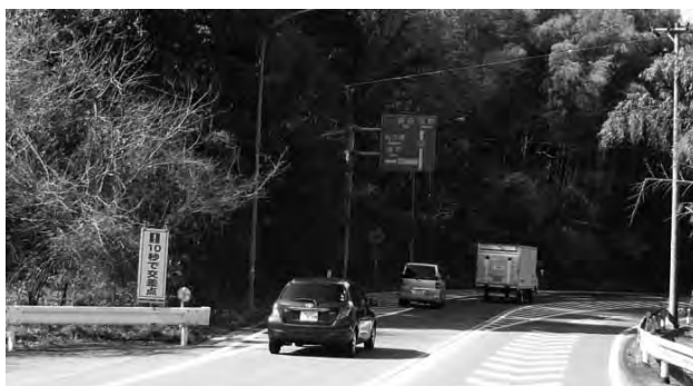
図-12 対策の試験実施（下り）
