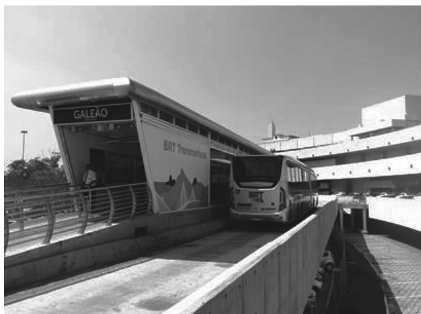
写真－2 国際空港に乗り入れているBRT
