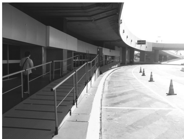
写真－5 国際空港に設置された仮設バス停
