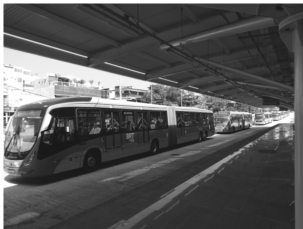
写真－4 地下鉄と一体となったBRT停留所
