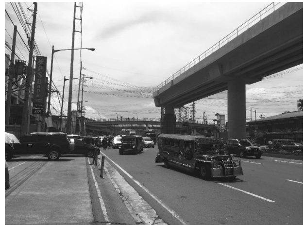
写真－2 LRT 2の東部延伸整備の現況
