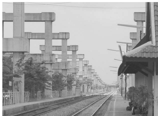
図-4 ホープウエルの橋脚
