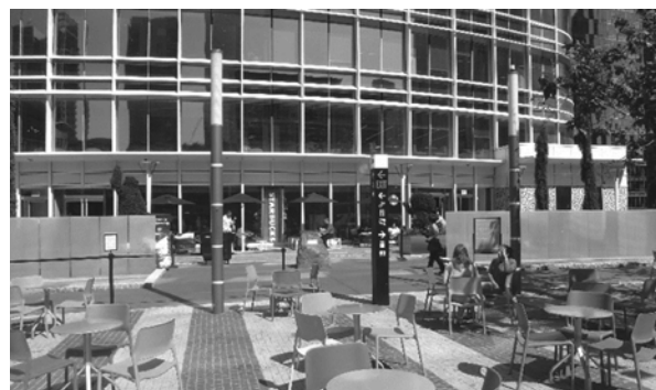
写真-1 隣接ビルとの接続部 (筆者撮影)
