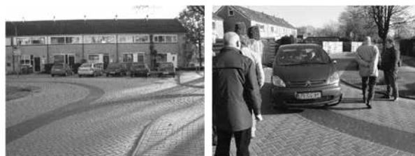
写真-2 整備後のヘッセルテルブリंक 2)・4)
