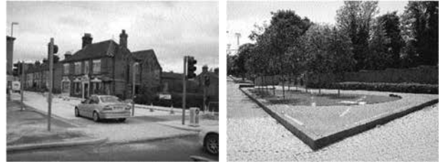
写真-8 整備後のハンドフォードロード 2)・4)
