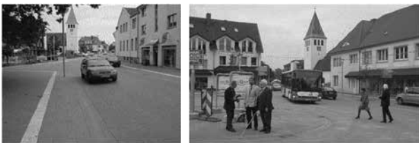
写真-5 整備後のブレーマー通り 3)・4)
