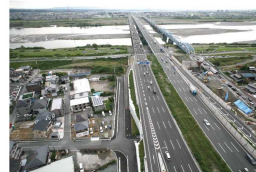
図 新天竜川橋(道路拡幅の例)
