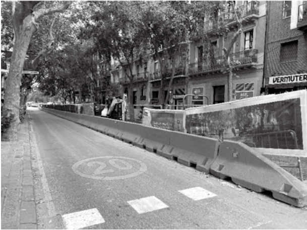
写真-11 車線数削減による歩行空間の拡大工事の様子 (IBS撮影)
