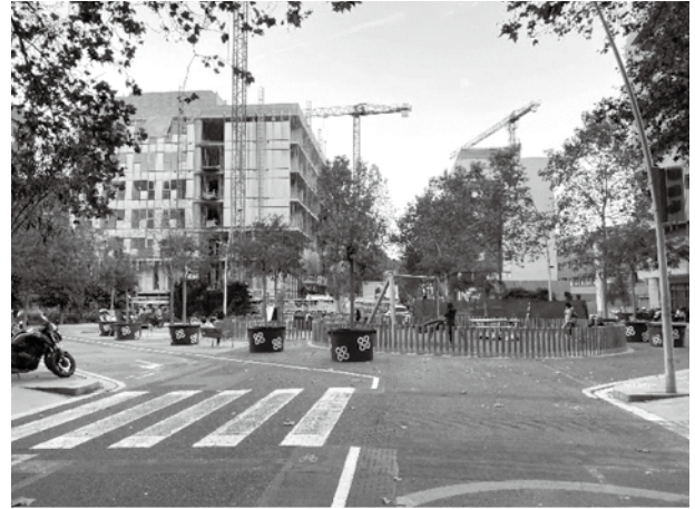
写真-14 スーパーブロックによる交差点の解消例 (IBS撮影)
