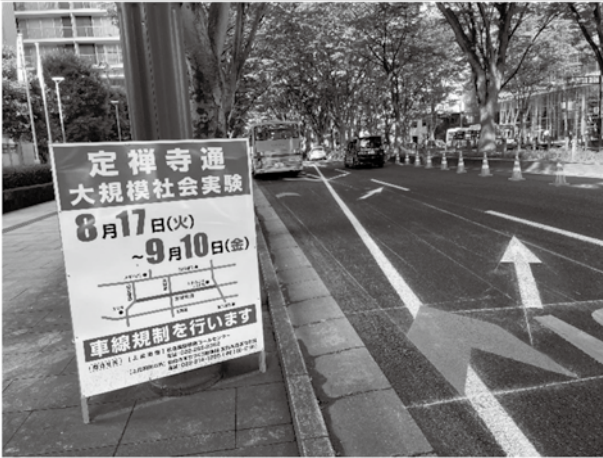
図-4 車線規制の様子 (IBS撮影)
