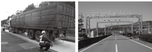
図-6 取締り基地(左)及び自動重量計測装置(右)
