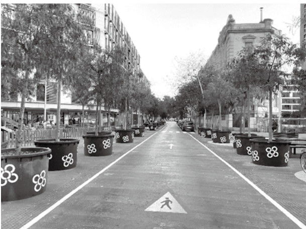
写真-13 車線を削減し単断面のまま植栽を設置した例 (IBS撮影)
