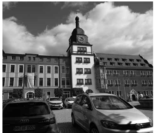
写真－1 駐車場となる市役所前広場
